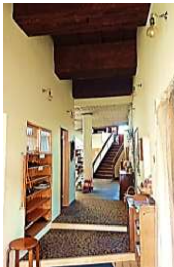
合成梁が見える天井の高い通路
